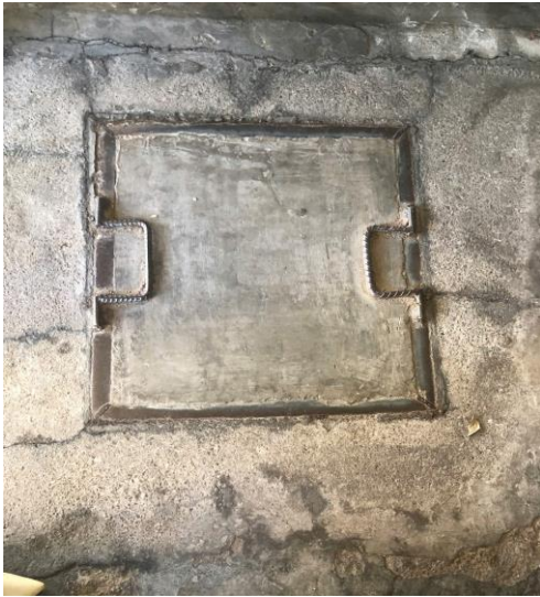
Hình 3.6. Bể xử lý sinh học
