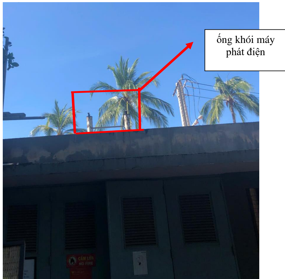
Hình 3.14. Hình ảnh ống khói máy phát điện
